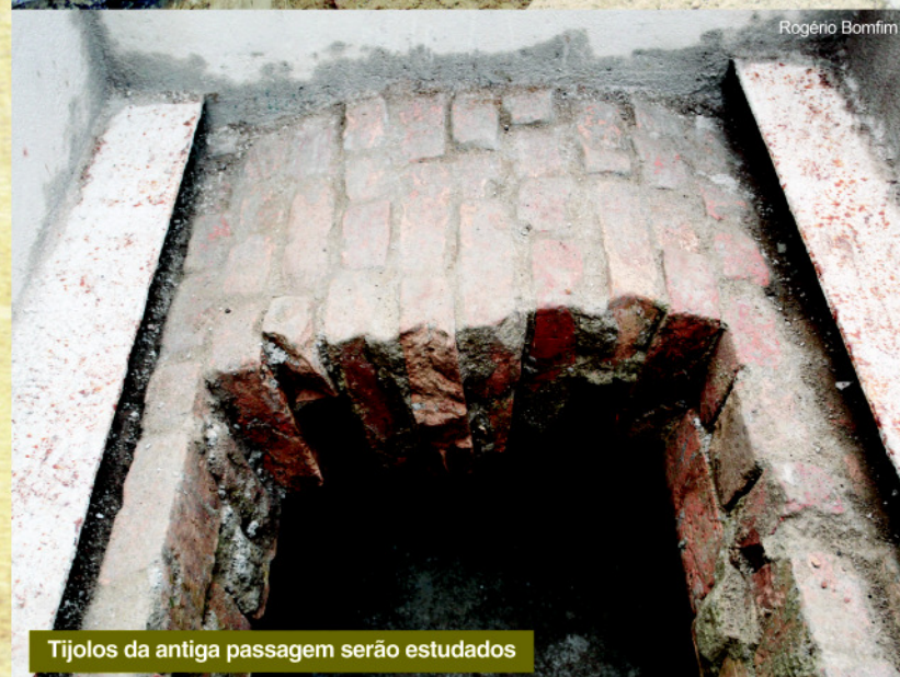
Acesso à galeria pela av. Ana Costa, próximo ao shopping
